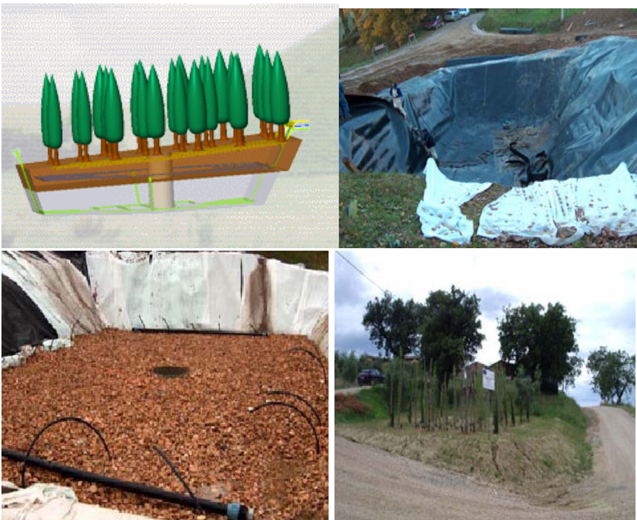
Εικόνα 6. Απεικόνιση της τεχνολογίας υπεδάφιας διάθεση υγρών αποβλήτων ελαιοτριβείου με το σύστημα OLEICO (με πλήρη προστασία του υδροφορέα).
