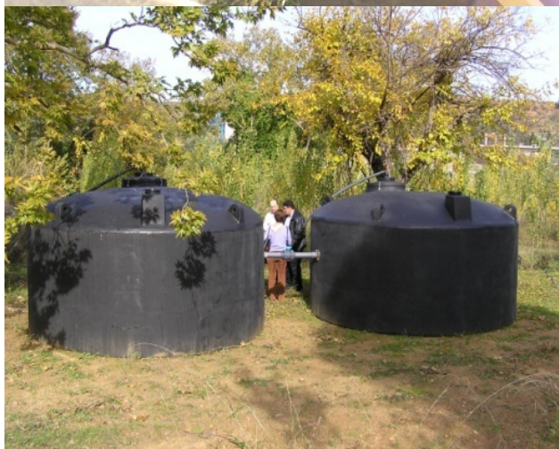
Εικόνα 5. Απεικόνιση της τεχνολογίας υπεδάφιας διάθεση υγρών αποβλήτων ελαιοτριβείου σε συνδυασμό με φωτοεξυγίανση - Ελαιοτριβείο ΚΟΚΟΛΗΣ (ΧΑΝΙΑ-ΒΑΣΙΛΑΚΗ)
